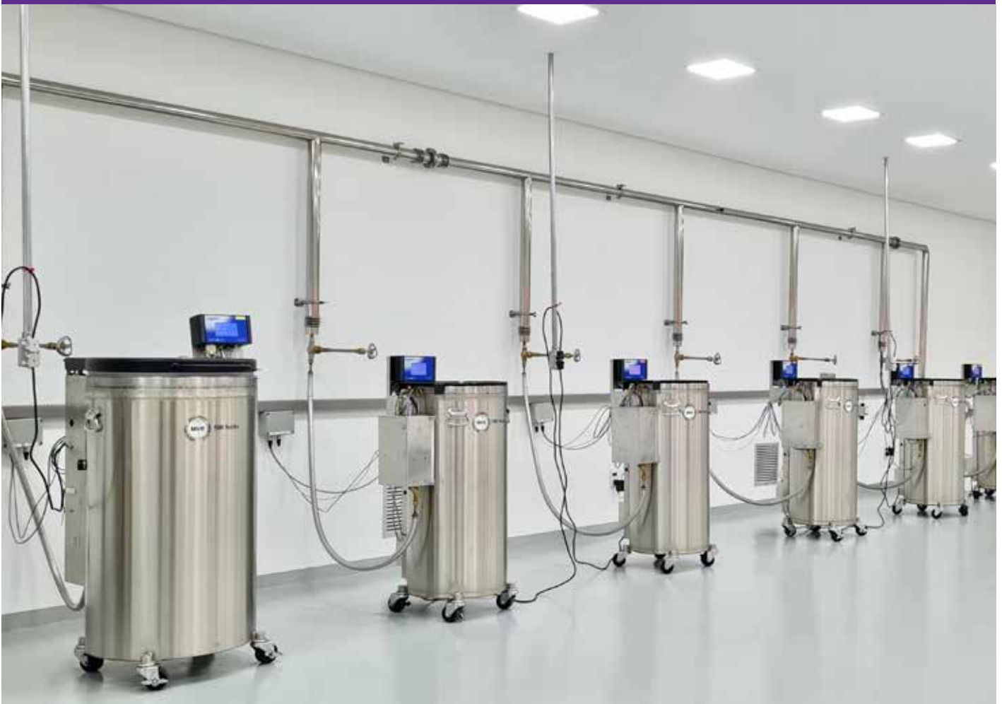
Voor het automatisch vullen en monitoren van de cryovaten maakt het Braziliaanse CryoForLife gebruik van de CryoFill vulautomaten van Cryo Solutions in combinatie met het XiltriX alarm- en monitoringsysteem.
